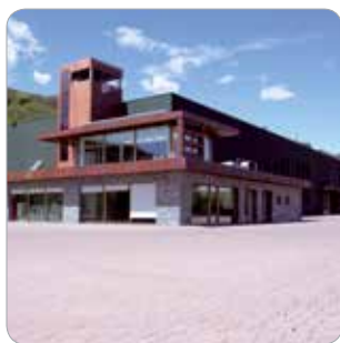
NEW PRODUCTION UNIT San Maurizio d'Opaglio (NO)
